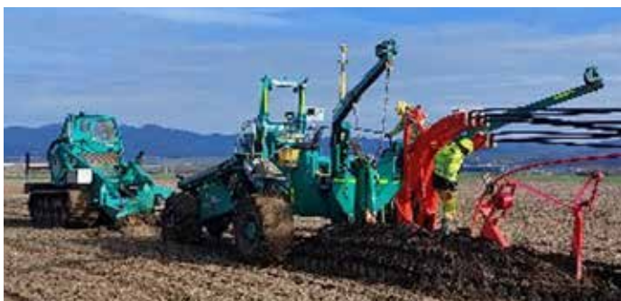
Pluhování el. kabelů (tříkrát vn-systém = 9 kabelů)
