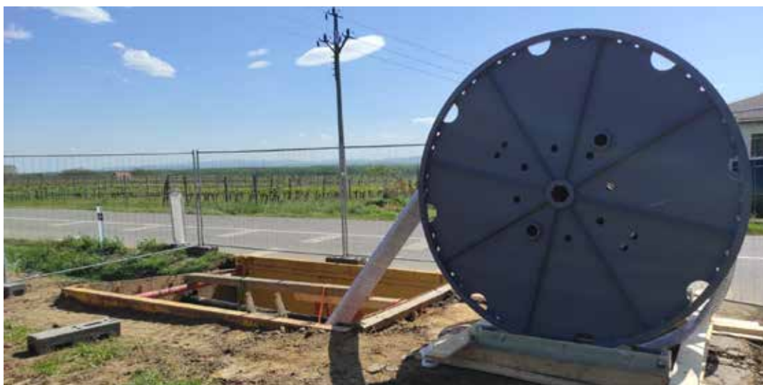
Obr. 7 – Zatahování vložky v Tvrdonicích s minimálními požadavky na zábory
