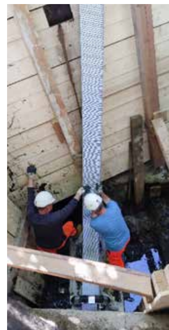
Obr. 3 a 4 – Zatahování vložky Primus Line
