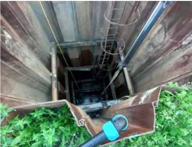
Obr. č. 8 Startovací jáma Zdroj: Fotodokumentace stavby TALPA-RPF
