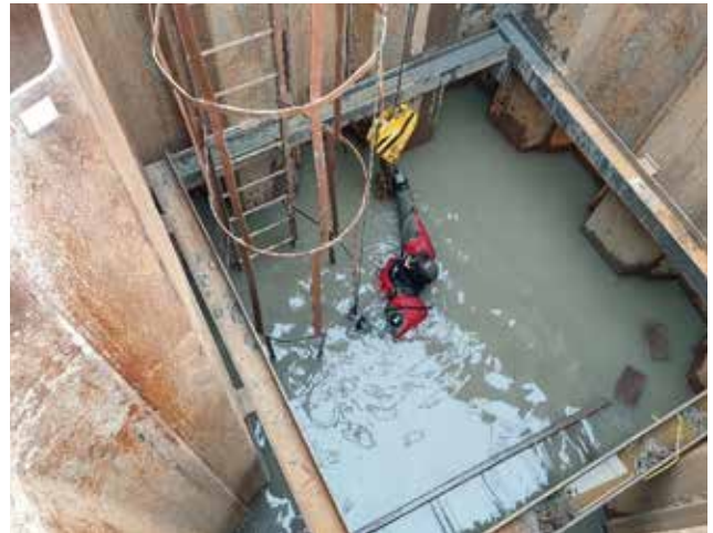
Obr. č. 9 Kontrola stavu startovací jámy po zaplavení Zdroj: Fotodokumentace stavby TALPA-RPF
