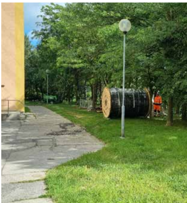
Obr. 2 – Vložka Primus Line v délce 508 m připravená k zatažení
