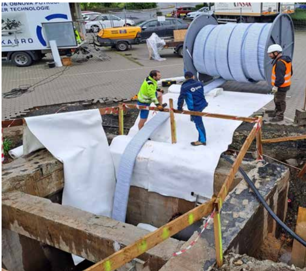
Obr. 11 – Instalace vložky Primus Line s minimálními nároky na zábory
