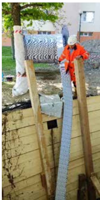
Obr. 3 a 4 – Zatahování vložky Primus Line
