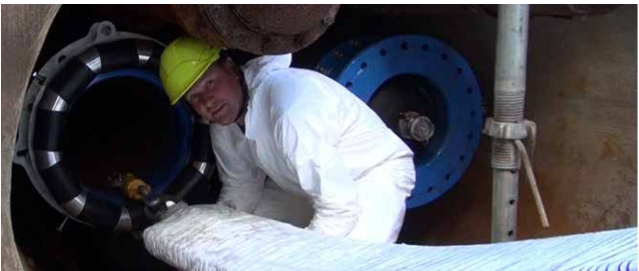
Obr. 10 – Instalace vložky Primus Line v kolektoru
