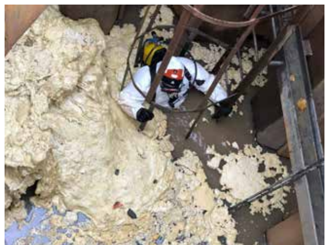
Obr. č. 11 Injektáž polyuretanem za ostěním Zdroj: Fotodokumentace stavby TALPA-RPF
