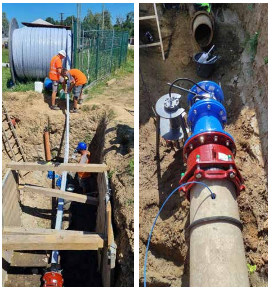
Obr. 5 a 6 – Zatahování vložky Primus Line, Montáž přírubového konektoru R1 v Mohelnici
