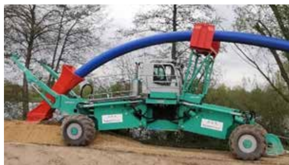
Pluhování vodovodu (DA500mm HDPE)
